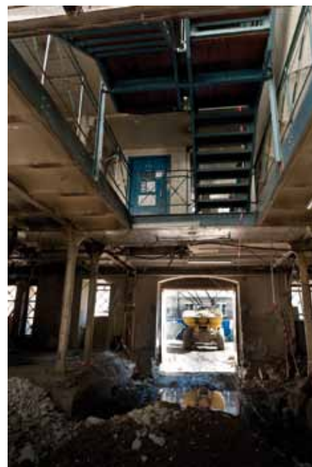
La BNU en chantier Phot. BNU-JPR 2011
