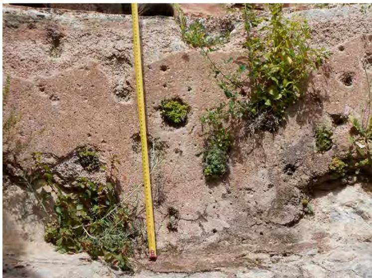
**Figure 9. Traces de l'explosion sur les parois de la citerne**
