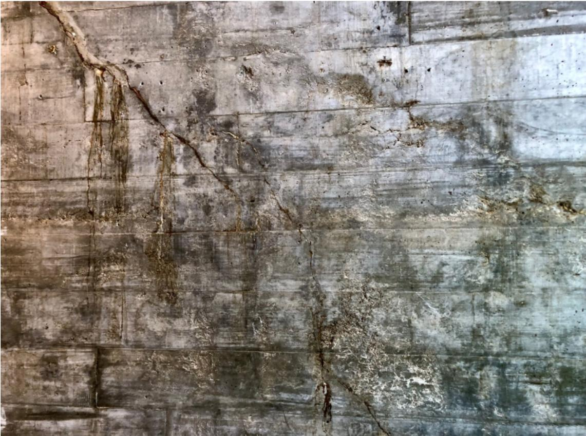
Détail d'un mur en béton brut de décoffrage du Museu de arte moderna de Rio de Janeiro (architecte Affonso Eduardo Reidy), achevé en 1955, partiellement détruit par un incendie en 1978
